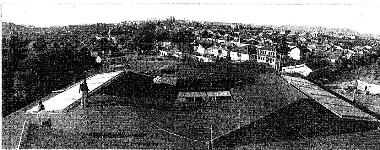
2 x 30 m 2 Sonnenkollektorfelder auf dem Dach des Spitals in Gjakova
